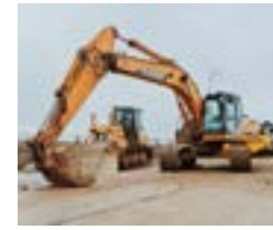
Strassen-Sanierungen im Dättnau
