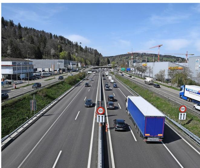
Mit dem 6-Spur-Ausbau ab ca. 2035 würde die A1 von derzeit 24 auf 32 Meter verbreitert.
